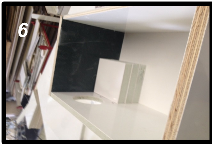
Pose des cales
