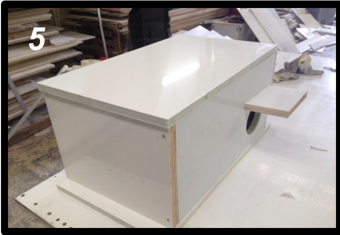
Pose du dessous
